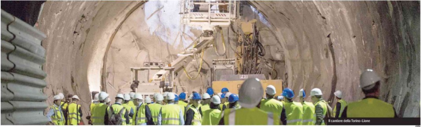
Il cantiere della Torino-Lione
